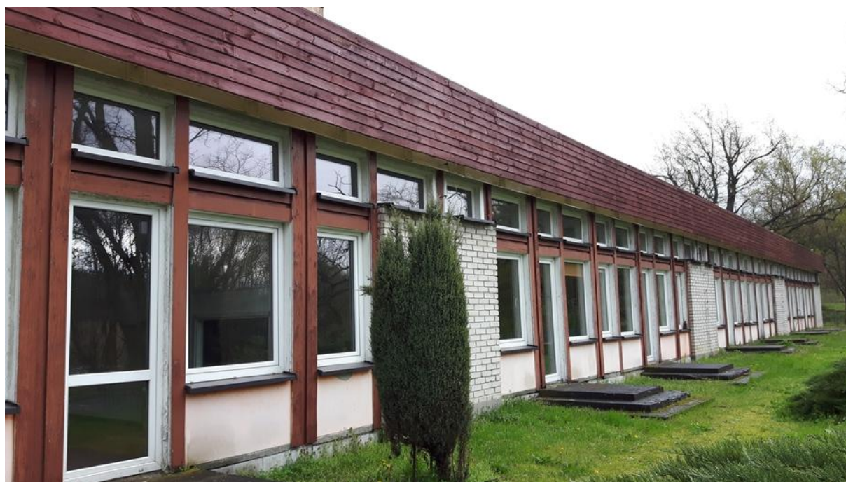
Fot. nr 11. Przedszkole – widok elewacji południowej.
