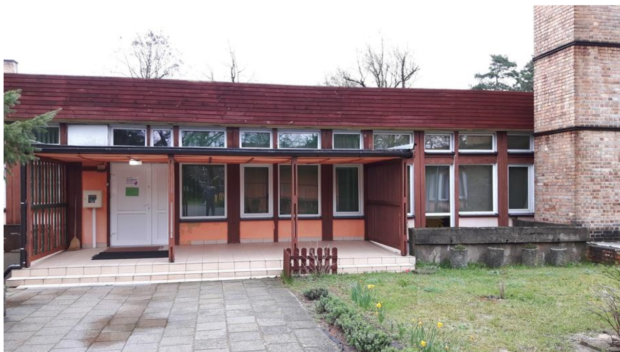
Fot. nr 12. Przedszkole – widok wejścia głównego od strony południowej.
