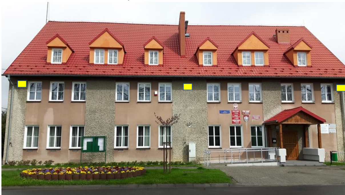
Fot. nr 1. Urząd Gminy – widok elewacji frontальной. Żółte prostokąty – miejsca planowanych budek.
