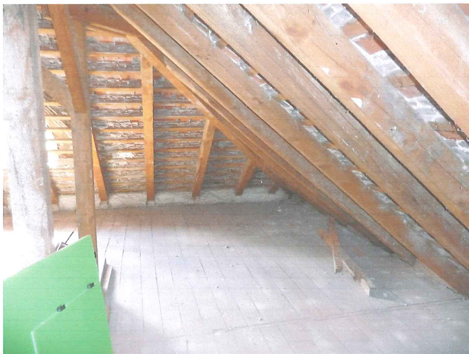
Fot. 2. Widok na strych (planowane ocieplenie stropu) – dach szczelny po niedawnych remontach. Brak śladów bytności ptaków.
